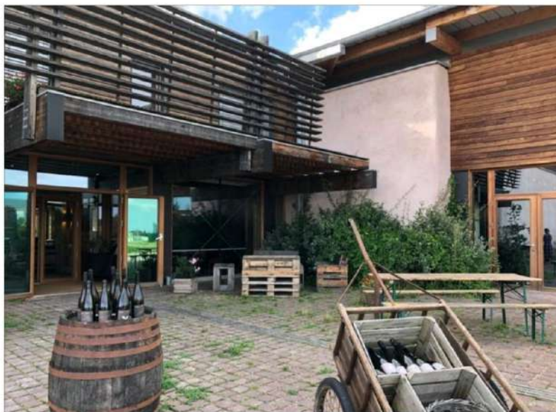
L'espace d'accueil du chai Achillée, entièrement vitré, relie le cave et l'espace de stockage, entièrement en paille. Photo L'Alsace
