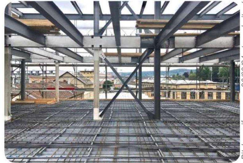
Remise en oeuvre des poutrelles
