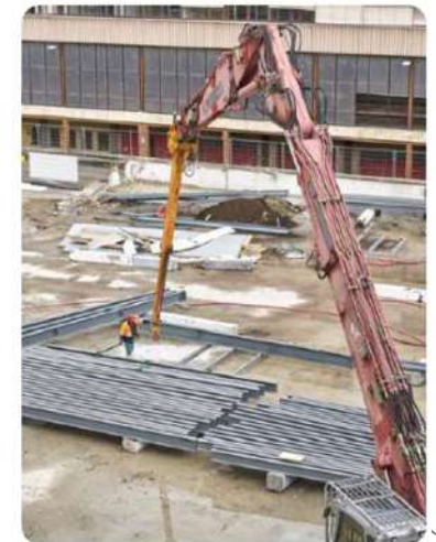
Récupération des poutrelles
