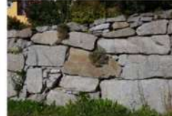
Mur de soutènement en granite. Aubeure
