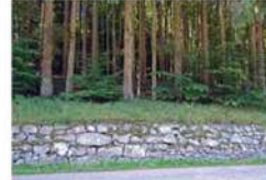
Mur de bord de route en granite. Waldersbach
