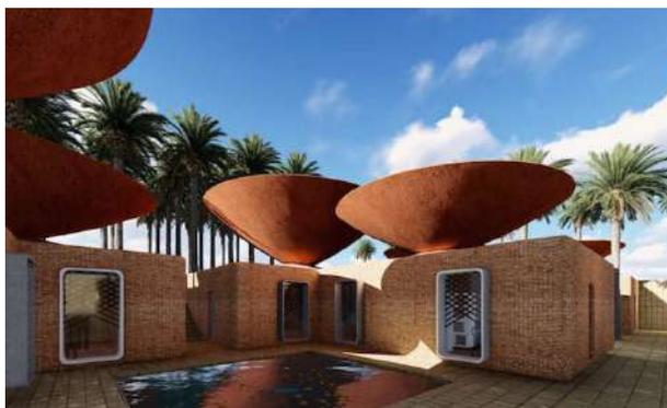
**Des toitures concaves pour récolter l'eau de pluie et la rosée - protection solaire - rafraîchissement**
